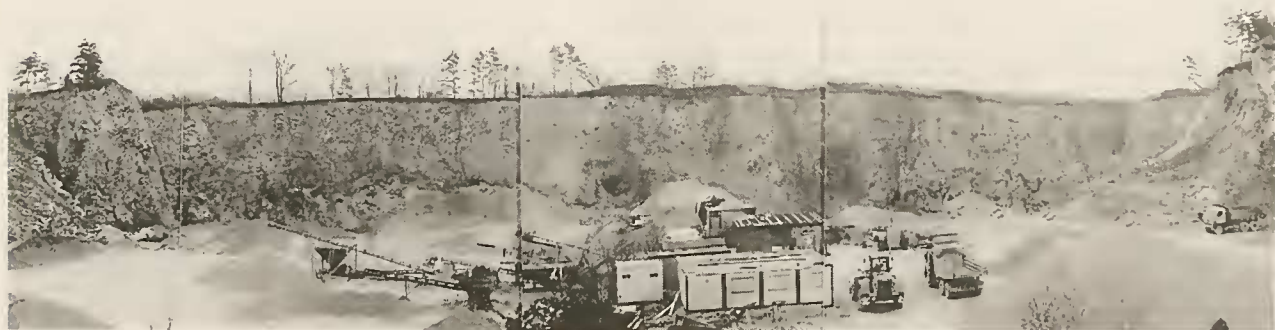
Abb. 2: Ansicht der Ostwand des Steinbruchs am Steinberg. Fotos von H. HABERL, November 1998.
